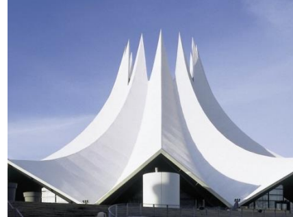
Στεγανοποίηση Δωμάτων (Roofing)
