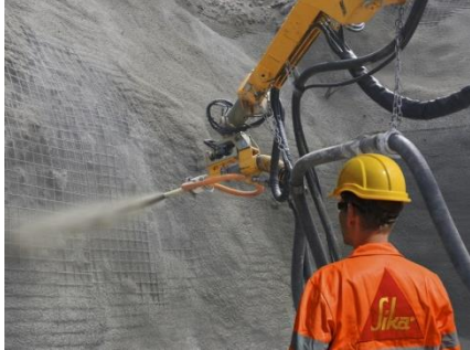
Παραγωγή Σκυροδέματος (Concrete)
