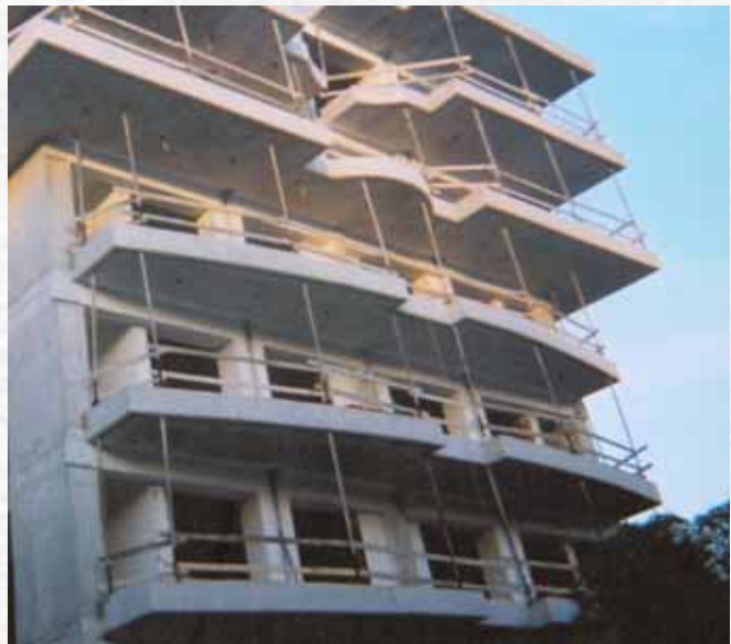
Ασφαλής προστασία με πατοκολώνες και οικοδομικό πλέγμα / σανίδια.
