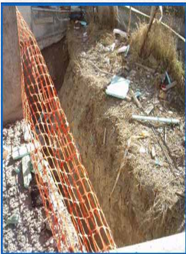
Σήμανση πλάκας στο άκρο της εκσκαφής
