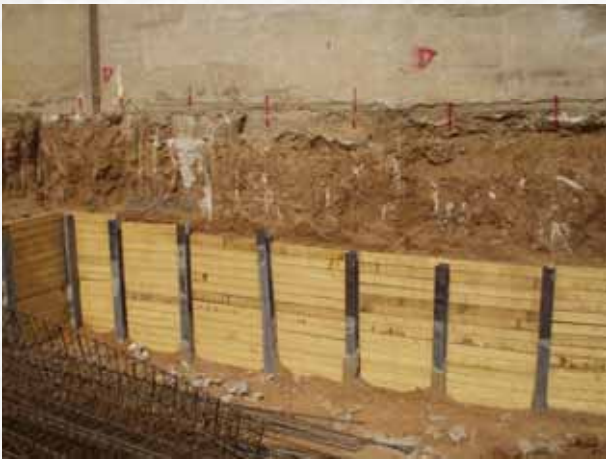
Αντιστήριξη θεμελίων κτιρίου
